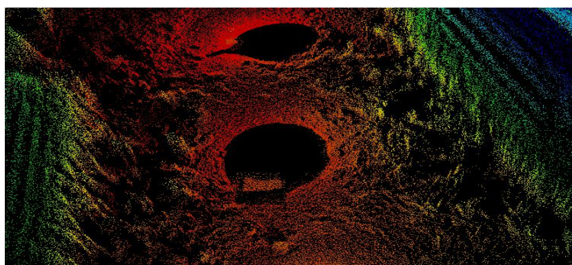
图5.3.9-4 中孔河床大块石及出露桩头图
