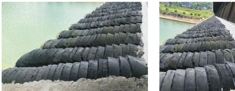
图 16 安化风雨桥廊屋顶盖小青瓦(摄于 2020 年 8 月)
