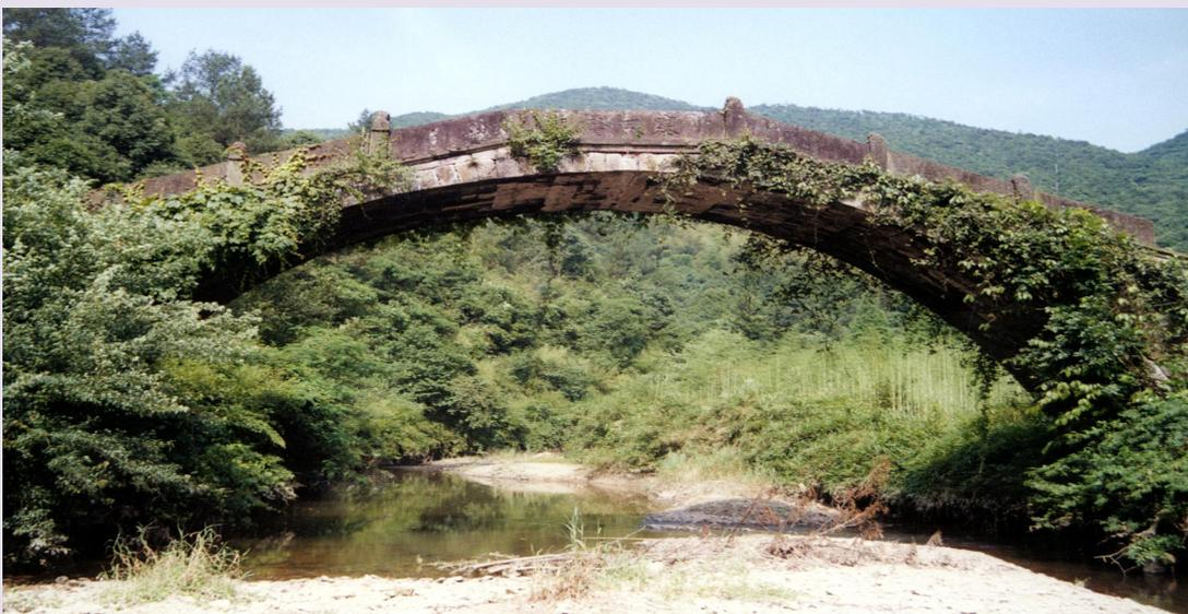
寨口桥位于绍兴县夏履乡莲增村的莲花岗与岩山之间，系用 90 块长条石横向并列砌筑的山区石拱桥。桥长 30 米，宽 2.6 米，高 10 米。此类桥拱为石桥中少见，在清嘉庆《山阴会稽志》中有载，桥重修建于清光绪十二年（1886 年）八月，离桥二十米有桥亭一座，内有建桥碑记石一块。
