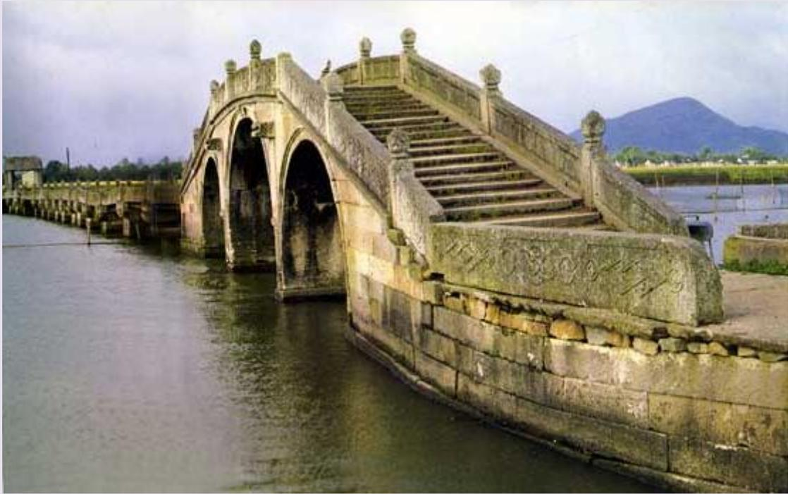
泗龙桥位于绍兴市鉴湖乡鲁东村，由三孔石拱桥与二十孔石梁桥组成，全长 96.4 米，宽 3 米。三孔拱桥净跨为：5.4 米、6.1 米、5.4 米。此桥气势宏伟，景观秀美，是绍兴重要的水乡旅游景观。对照宋嘉泰《会稽志》，此桥当为古代鲁墟桥，在桥的一侧有桥对：建近千年路达南北，名驰廿眼水通东西。说明该桥始建于宋朝。此桥在《中国科学技术史》桥梁卷有载。
