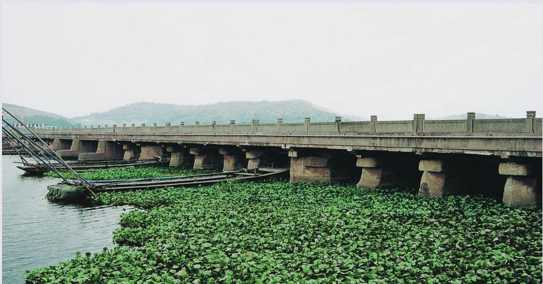
汤公桥位于绍兴三江，又称三江应宿闸，是桥闸合一的石桥，也是绍兴三江古入海口的大型水利设施和交通设施。此桥始建于唐太和七年，现桥为明绍兴太守汤绍恩重建，此举世世代代恩泽越北平原。现桥长 108 米，宽 9.16 米，28 孔，为石墩石梁长桥，每孔以星宿命名，故称应宿闸。此桥气势雄伟，为古代少见的特大型工程设施。原桥现存一半，新老桥合一，为县级文物保护单位。
