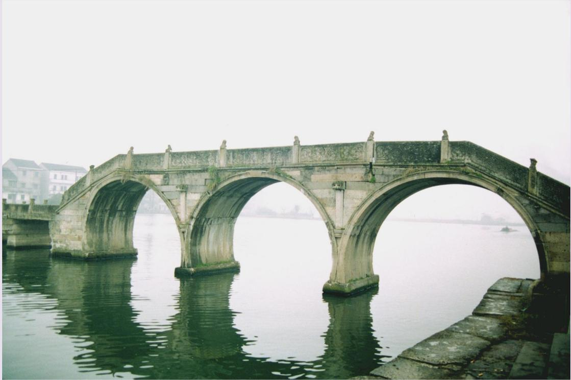
泾口桥位于绍兴县泾口村，跨浙东运河。该桥由三孔马蹄型拱桥与三孔石梁桥组成。拱桥高6米，三孔等跨，长20米；梁桥高3米，长10米。桥重建于清宣统三年。此类桥型为国内少见。该桥为县级文物保护单位，并在《中国科学技术史》桥梁卷中有详细论述。
