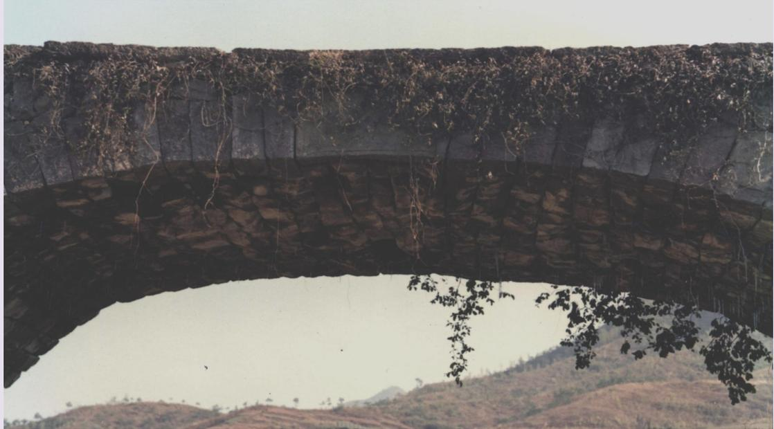
迎仙桥位于新昌县桃源乡，为悬链线拱的乱石拱桥。该桥在明万历《新昌县志》有载。清代道光时，丁天松重修。1991年发现了该桥型，从此填补了中国石桥技术史的空白。悬链线拱桥是二十世纪六十年代世界先进桥梁科技，此项技术中国要早于国外500多年。迎仙桥长29米，宽4.6米，净跨15.6米，现已定为省级文保单位，在《中国科学技术史》桥梁卷有载。
