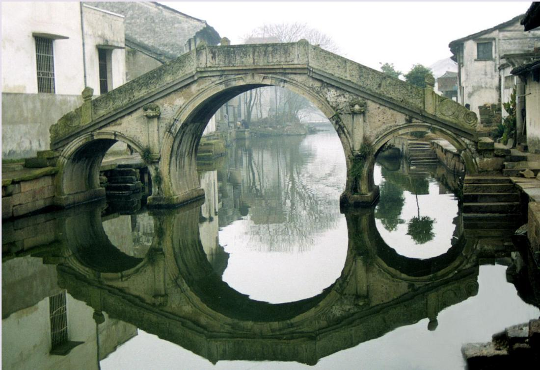
酒桥又名新桥，位于绍兴酒的著名产地东浦镇，名为新桥，实为石桥，此桥为连续三孔马蹄型拱桥，中孔高，二边孔低，故称驼峰拱桥，桥型优美。
