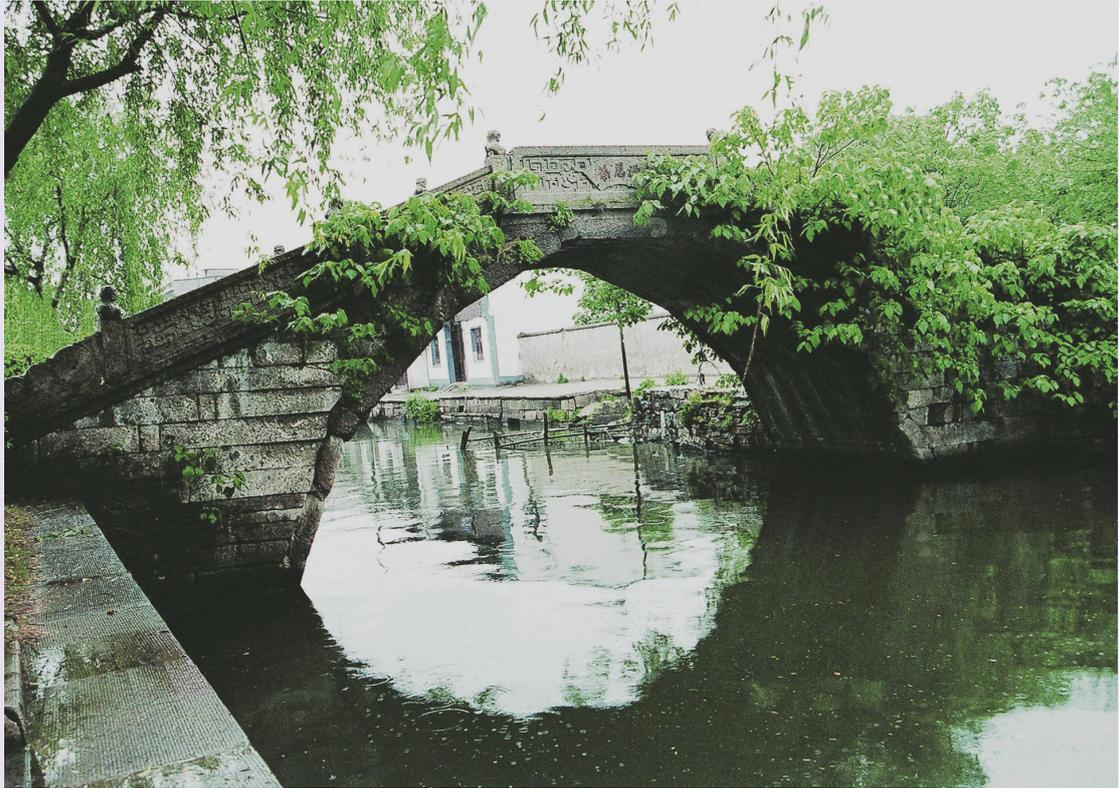
迎恩桥也称菜市桥，位于绍兴市区西郭，在运河进城口子处，石代绍兴水路进城的西门户。皇上驾临绍兴，百官迎候在此，故取名迎恩桥。孙中山来绍兴时，绍兴各界也在此欢迎。该桥为七折边石拱桥，是绍兴市跨度最大的七折边石拱桥。现桥为明天启六年（1626）重修，始建于何时待考，桥长 15 米，宽 3.4 米，净跨 10 米。此桥收录于《中国科学技术史》桥梁卷，是世界上仅存于绍兴的 6 座七折边拱桥之一，是世界上仅存于绍兴城区的 4 座城市七折边拱石桥之一。
