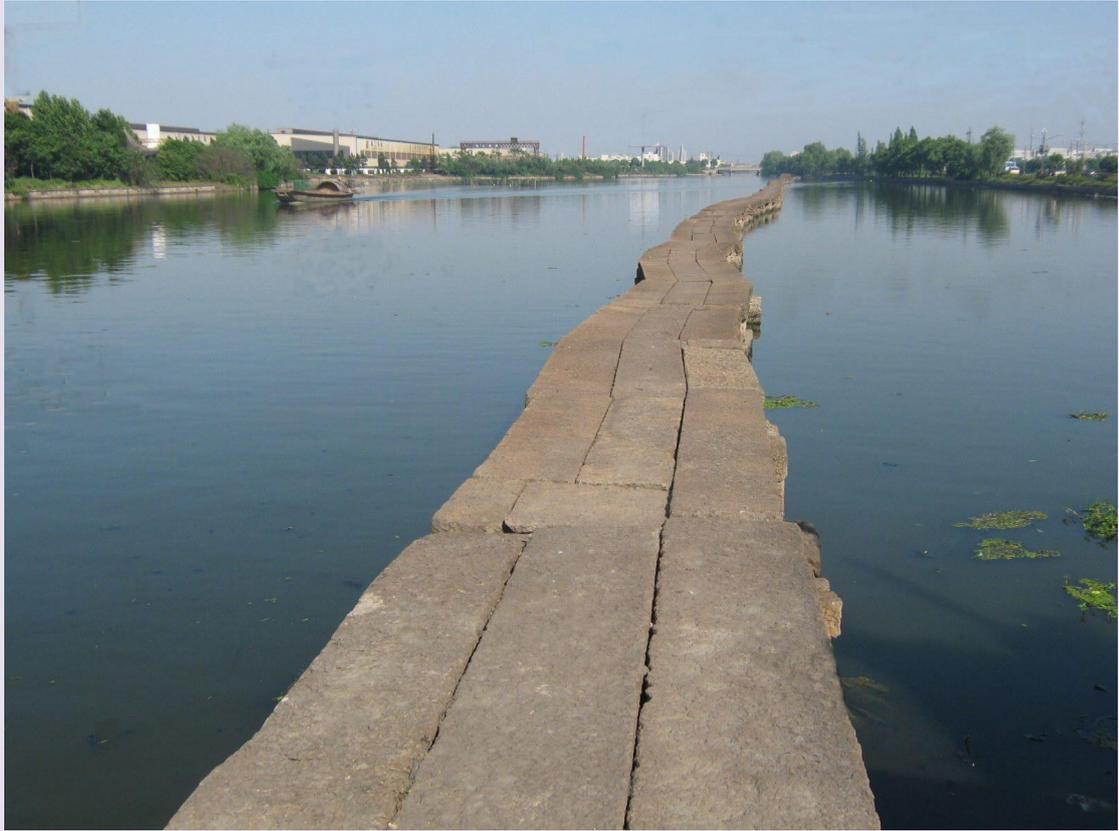
纤道桥系全国重点文物保护单位，现存古纤道为唐元和十年（815）浙东观察孟简整治运河时修筑，全长一百多里。其中最长的一段全长 386.2 米，由 115 跨石梁桥构成，为特长型石墩石梁桥。因其始建于唐，此桥型为国内仅存，为全国文物保护单位。此桥在《中国科学技术史》（桥梁卷）中有载。
