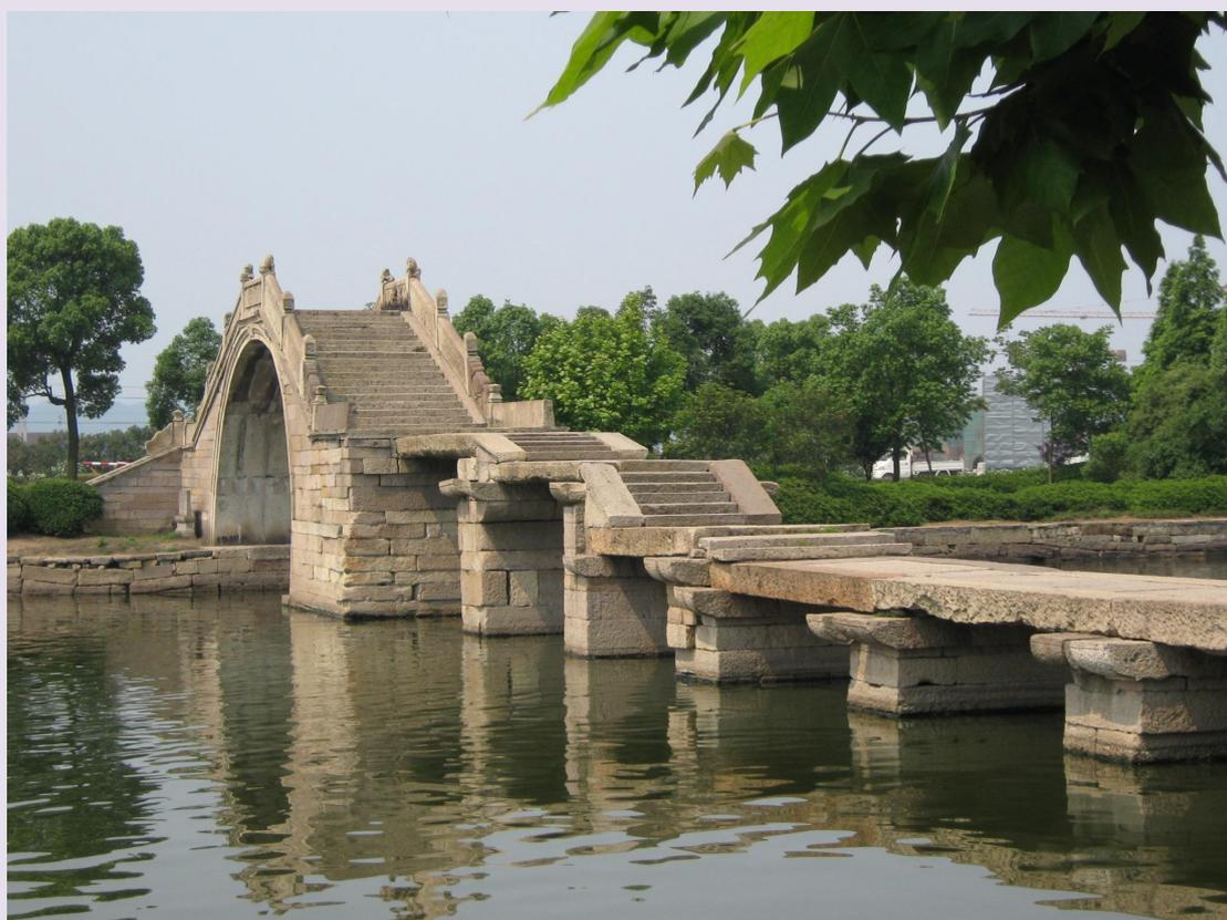
太平桥位于绍兴县阮社，该桥由一座半圆拱桥与九孔高低石梁桥组成。桥长 50 米，主孔净跨 10 米，石梁桥孔径 3-4 米。拱桥桥拱系纵联分节并列砌筑，拱桥南端八字落
