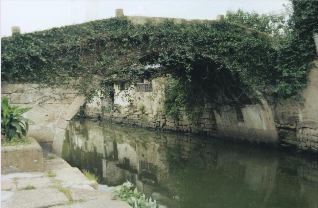
谢公桥位于绍兴城区西小路，鲤鱼桥与北海桥之间，为七折边石拱桥。经考证，因南朝太守谢惠连建此桥，取名谢公桥。此桥当为南朝始建，清康熙时虽作重修，但拱卷未变，仍采用旧料，宋《嘉泰会稽志》有载，故可定为宋朝以前石桥。此桥拱顶石刻图案中的龙为三爪龙，宋朝以后才出现四爪龙和五爪龙，这也可旁证此桥始建于宋朝以前。此桥桥长 28.5 米，净跨 8 米，高 4.2 米。谢公桥北枕卧龙山，山色街景桥影，构成了水城石桥佳景。此桥收录于《中国科学技术史》桥梁卷，是世界上仅存于绍兴的 6 座七折边拱桥之一，也是绍兴城区的 4 座城市七折边拱石桥之一。
