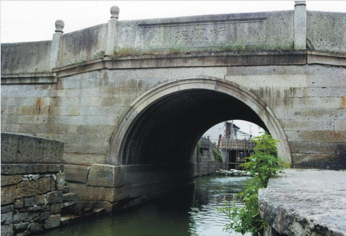
东双桥目前在通汽车，说明石桥的结构合理。东双桥位于绍兴市区东街路东首，在宋嘉泰《会稽志》有载，单孔半圆拱桥，并列砌筑，与光相桥桥拱的砌筑相同。桥长 20 米，宽 8.4 米，高 4.3 米，拱高 2.3 米，桥跨径 4.8 米。此桥东端置南踏阶，长 5 米，石阶下置桥，故此桥总称东双桥。此路西端也有一座同类型桥梁，称西双桥，已拆。此桥之所以称双桥是因为南落坡下有桥洞，南落坡实为一拱桥。此落坡桥与主桥组合故称双桥。桥前存放着原桥名石，桥名石下面图案与广宁桥抱鼓图案风格一致，可证明此桥名石为宋代原物，同时也可证明东双桥在宋代已存在。此石桥现通汽车。
