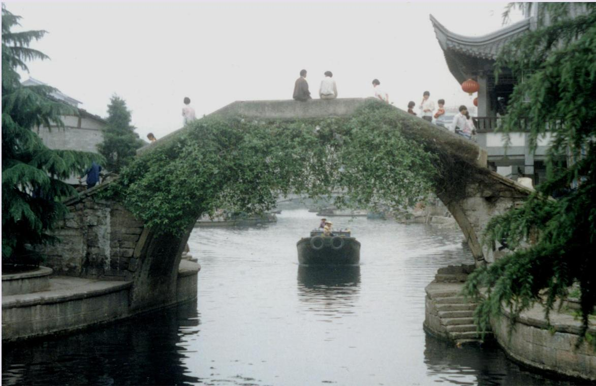
融光桥又名柯桥大桥，位于柯桥镇古运河上，单孔石拱桥。此桥长 17 米，宽 6 米，高 7 米，净跨 10 米，宋嘉泰《会稽志》有载。柯桥始建于汉代，现桥桥拱为链锁分节并列砌筑，现桥为明重建，重建时仍按宋朝时原桥型，仍用原石料，现仍可视其为宋桥。该桥在《中国科学技术史》桥梁卷中有载。
