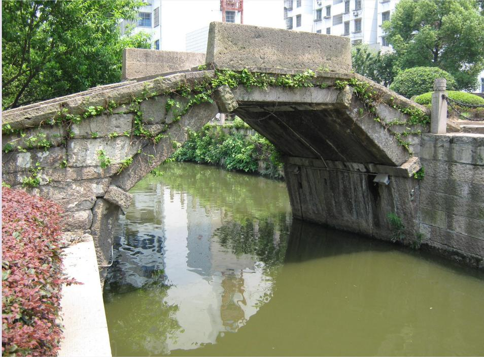
拜王桥在鲁迅西路凰仪桥侧，五折边拱桥。宋嘉泰《会稽志》载：“拜王桥在狮子街，旧传以为吴越武肃王平董昌，郡人拜谒于此，桥故以为名，桥长 30 米，宽 3.7 米，拱高 3 米，净跨 4.2 米。此桥应为唐桥，在《中国科学技术史》桥梁卷中有载，为国内仅存的城市五折边拱石桥，也是世界仅存的城市五折边拱石桥。
