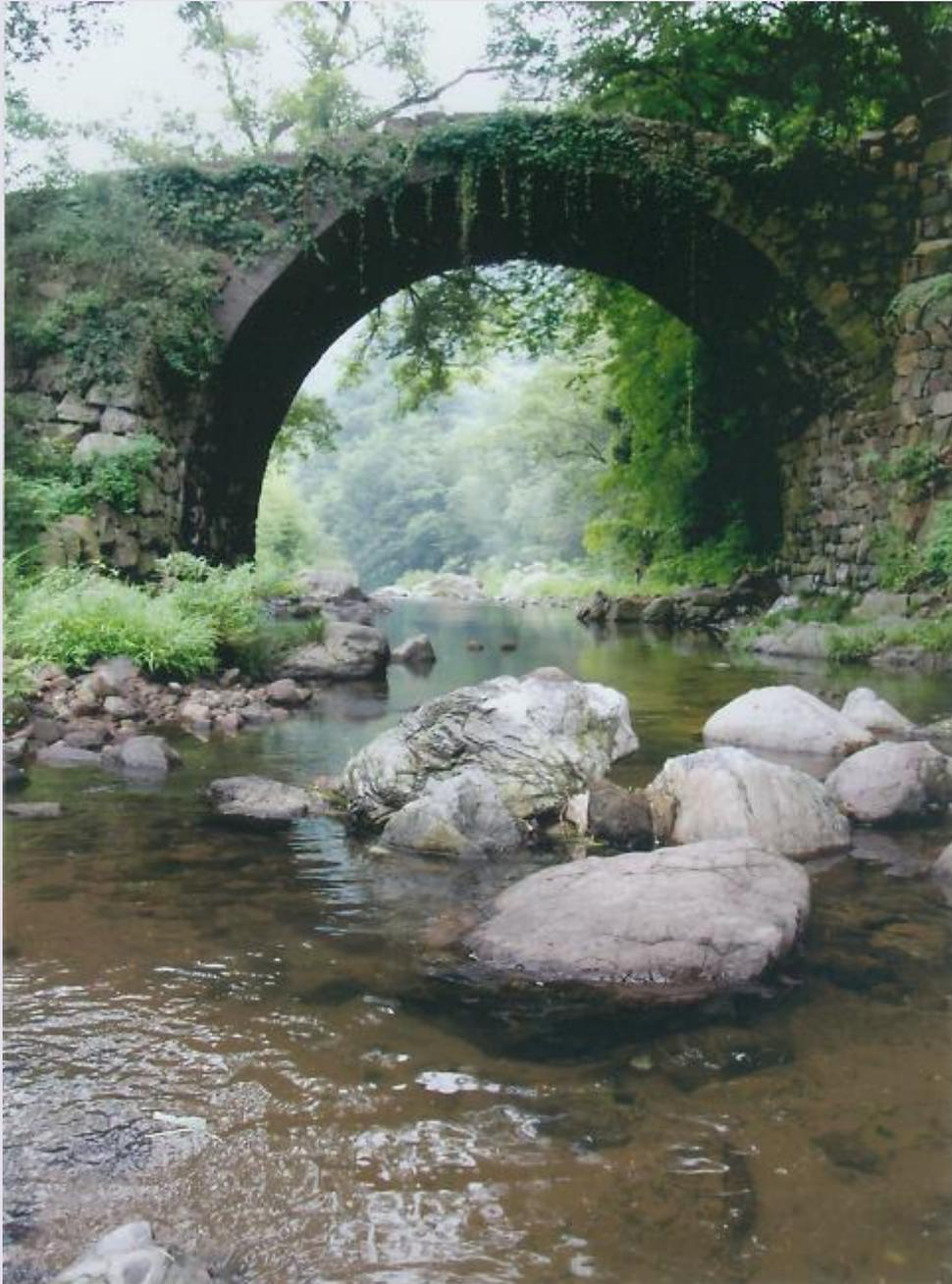
绍兴山区多乱石拱桥，这种乱石拱桥干砌成拱，完全靠规整的拱型成桥，技术含量较高。这种拱桥可能在远古时代就已存在，司马悔桥在新昌山区，因司马子微被征至此而悔得名，此桥在唐时已存在。
