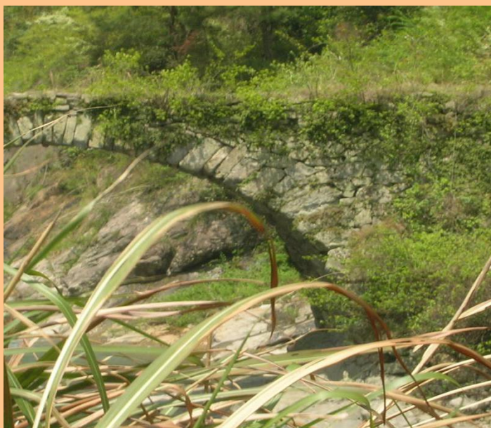
西坑大桥头桥变截面拱券
