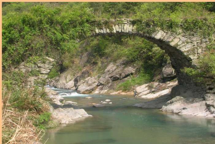
西坑大桥头桥
