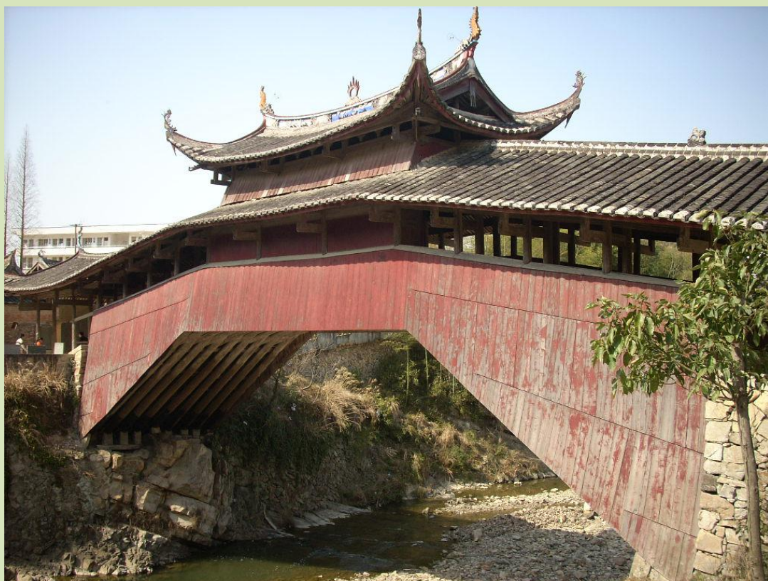
泰顺泗溪下桥
