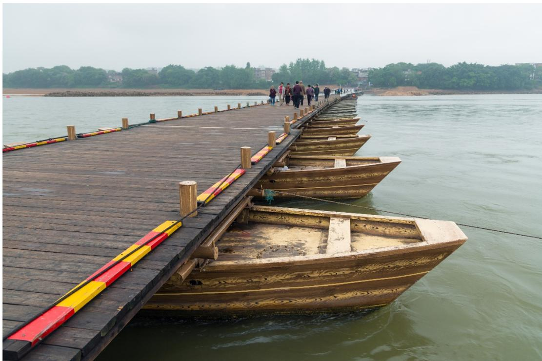
图 5 浮桥构造
