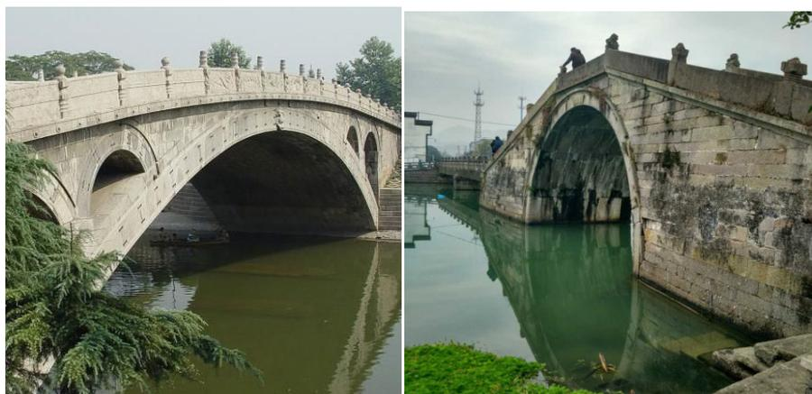
(a) 赵州桥（桥拱变幅6cm） (b) 西跨湖桥（全桥变幅26cm）
