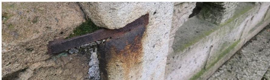
图 9：固定石板的钢筋与修补缝隙的灰色水泥
