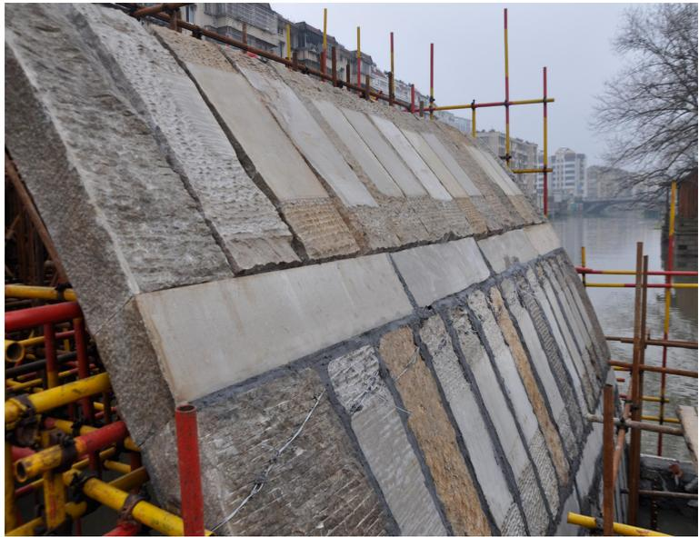
石桥拱券石安装采用满堂支架。为了满足河道清理船只通航，中孔预留宽 4 米，常年水位以上高 2 米的通航空间。石拱券从拱圈两侧，自下而上对称排列安装；每节拱券石严格控制于设计标高处，如有误差，立即调整；拱券石与龙筋石相邻处雌雄榫卯，依次至拱顶合拢；再对拱券石反面用填缝胶泥进行严密填嵌，防止上部混凝土拱板施工时因缝隙渗漏浆液对拱券石正面造成污染。
