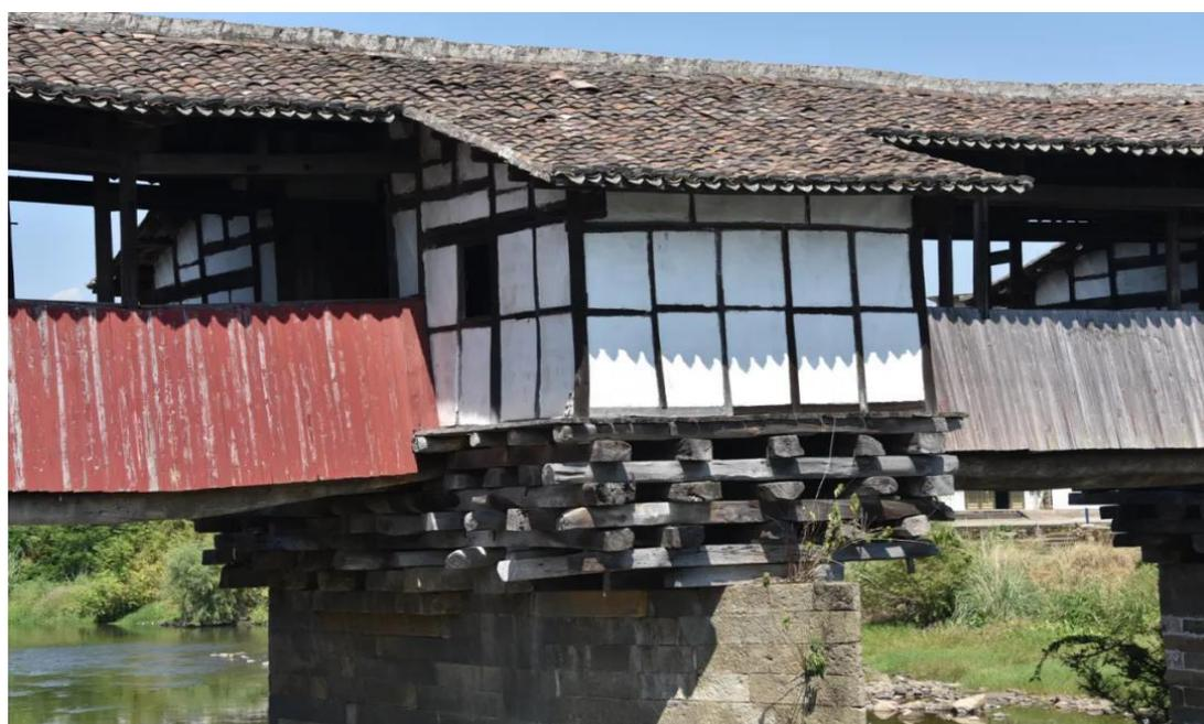
船型桥墩上方用 7 层粗大的枫木纵横交错作为底座，构成“喜鹊窝”的支架，这纵横交错的构建方式，倒是真的和喜鹊的窝有几分相似之处。
