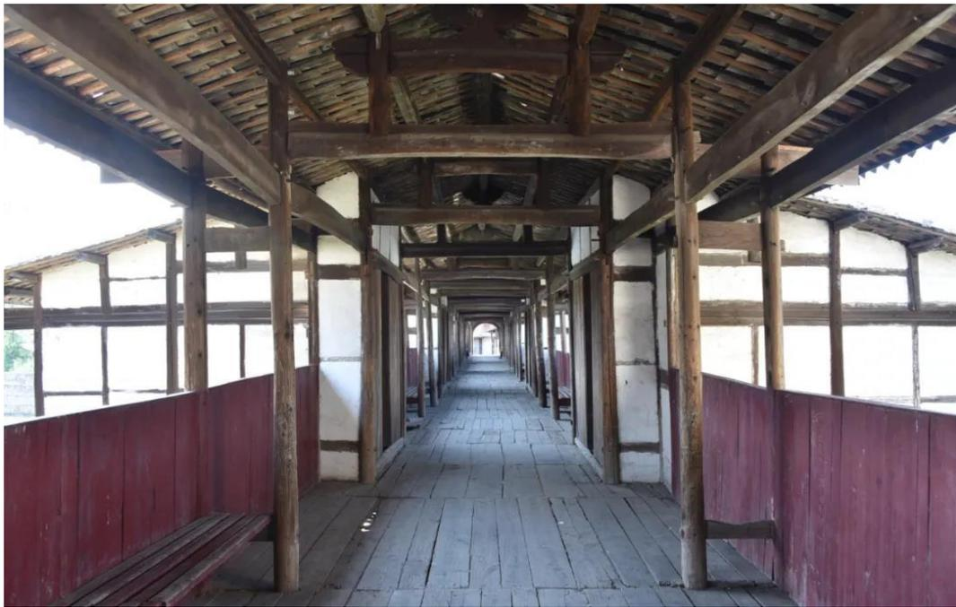
桥面上竖柱架梁，顶部为木抬梁结构，复以瓦盖，桥内通道宽约 4 米，桥面为木板铺就，两侧做有板壁，设有供休息用的条椅，它不仅能交通渡河，还能遮风避雨、纳凉休憩、交流买卖。
