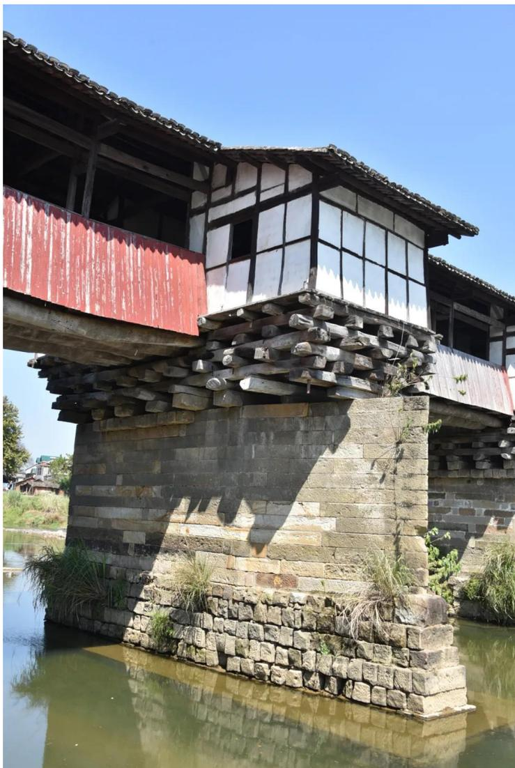
由于年久失修，目前桥身的木结构已经严重虫蚀，遍布虫眼，并引发了部分木料的断裂，如不尽早维修，有可能在下次洪水中被冲毁，希望有关部门能够重视，不要让这座一座独一无二的古廊桥，毁在新时代的洪流中。
