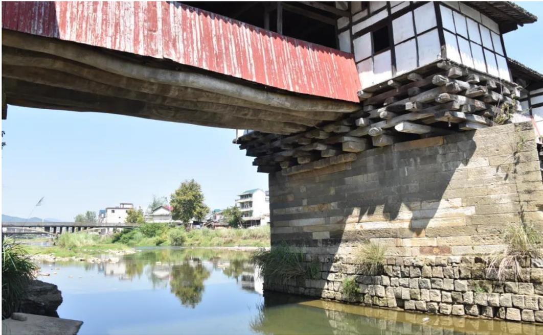
相邻桥墩间用 5 根 5 米多长、直径 20 多公分的枫木作梁，梁上再用厚实木板铺成桥面。
