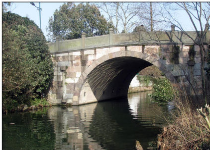
浙江古桥博览之流金桥
