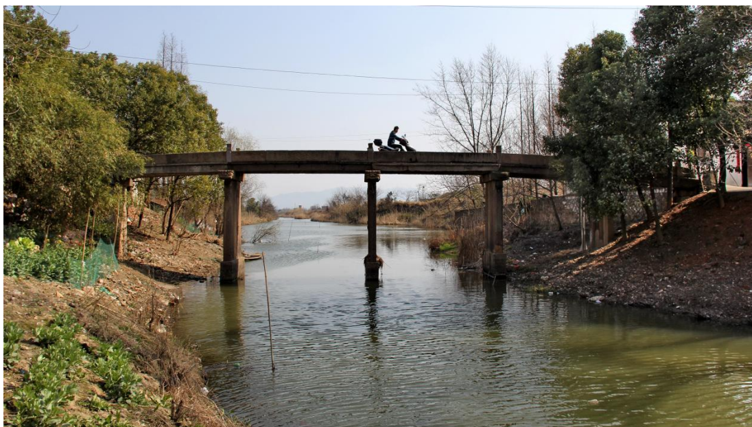
• 长兴县林城始建于七孔石梁桥畎桥
