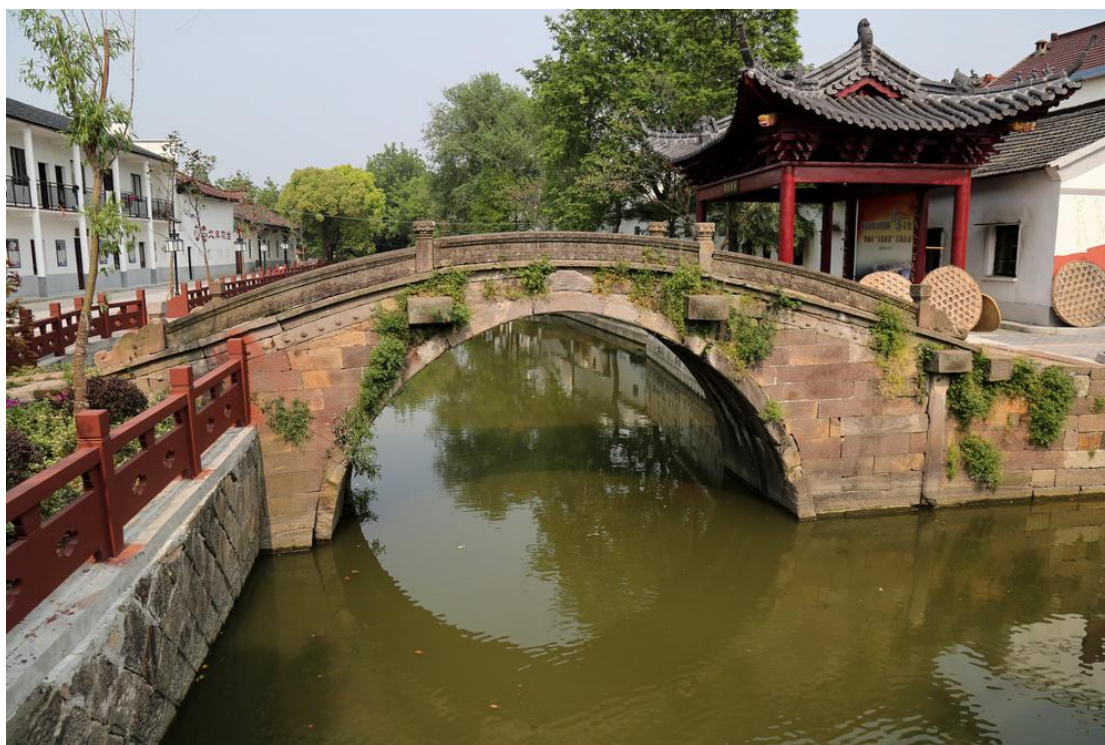
•全国文物保护单位德清古桥群之新安下舍万善桥
