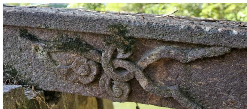
•南浔区菱湖镇许联村永安桥上纵梁侧面蔓草纹雕刻
