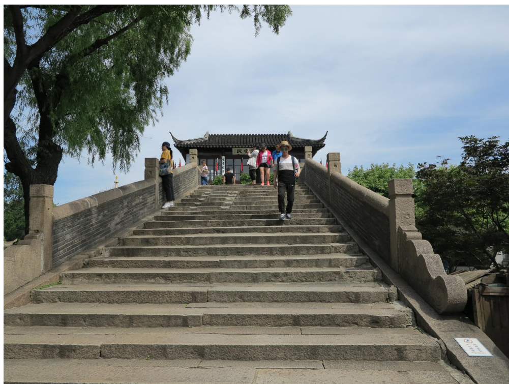
•枫桥西北端桥面
