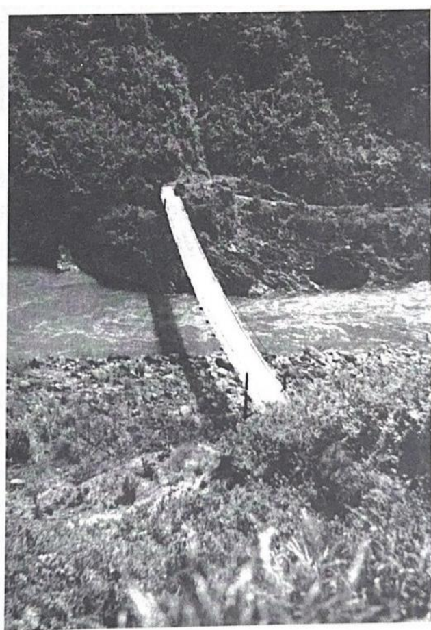
新安江上的铁索桥（老照片）
