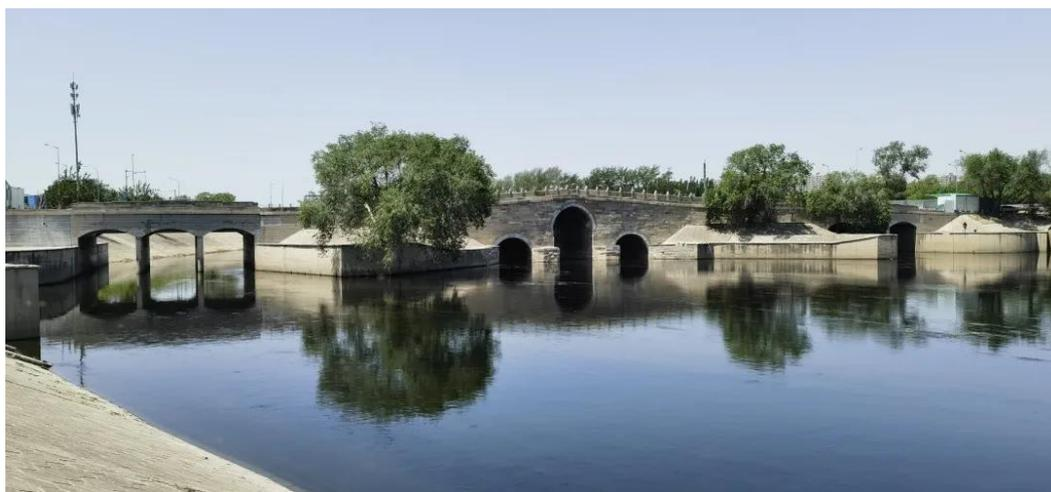
图 8 八里桥古桥及南北两侧钢筋混凝土三孔梁桥（摄影：王锐英）
