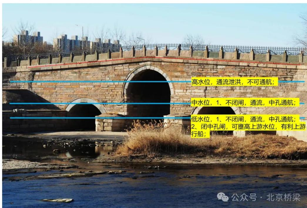
图 12 八里桥设置水闸作用推想示意图，只在低水位时发生闸门启闭（本文绘制）
