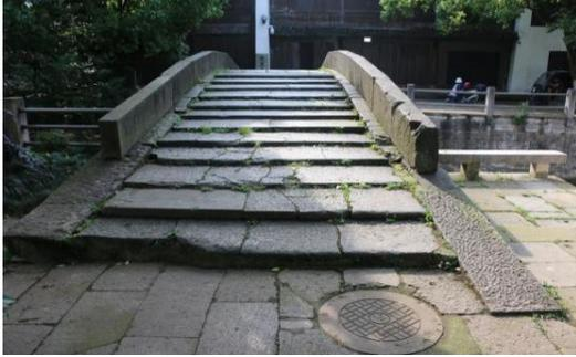
图 16 台阶石板断裂
