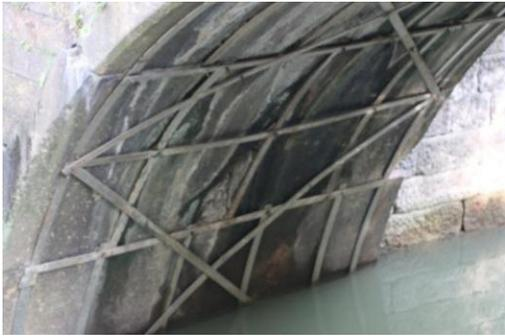
图 18 石块破损严重
