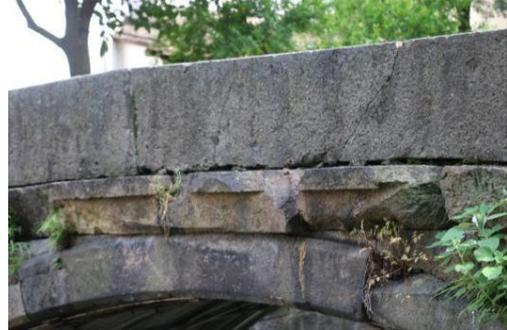
图 17 石板裂缝空隙
